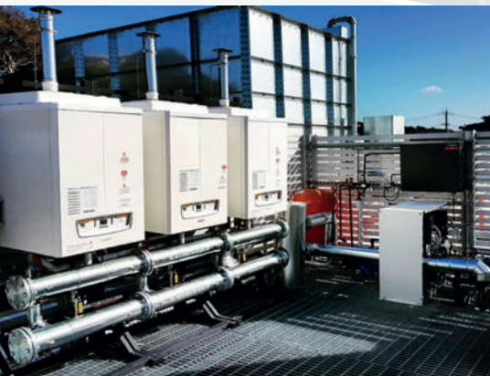
ΘΕΡΜΑΝΣΗ ΝΕΡΟΥ ΠΙΣΙΝΑΣ
