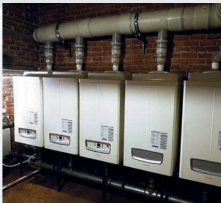
ΚΕΝΤΡΙΚΗ ΘΕΡΜΑΝΣΗ 600 kW
