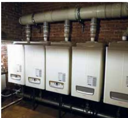
ΚΕΝΤΡΙΚΗ ΘΕΡΜΑΝΣΗ 600 kW
